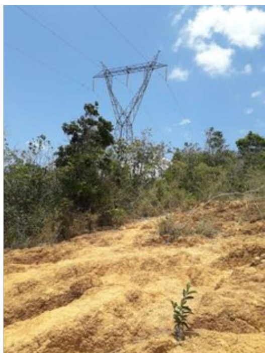
Figura 16 - Torre de transmissão rede elétrica na Reserva
