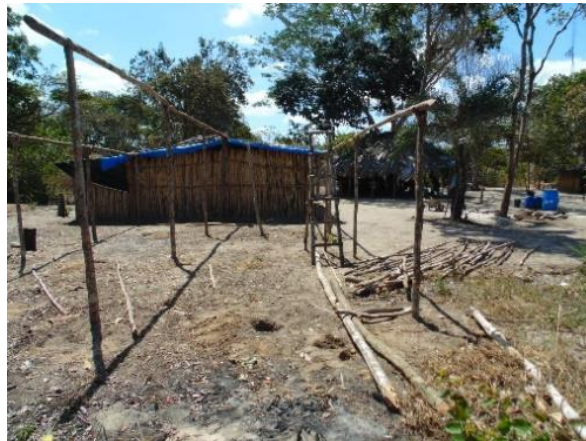
Figura 8 - Casas em construção na Reserva
