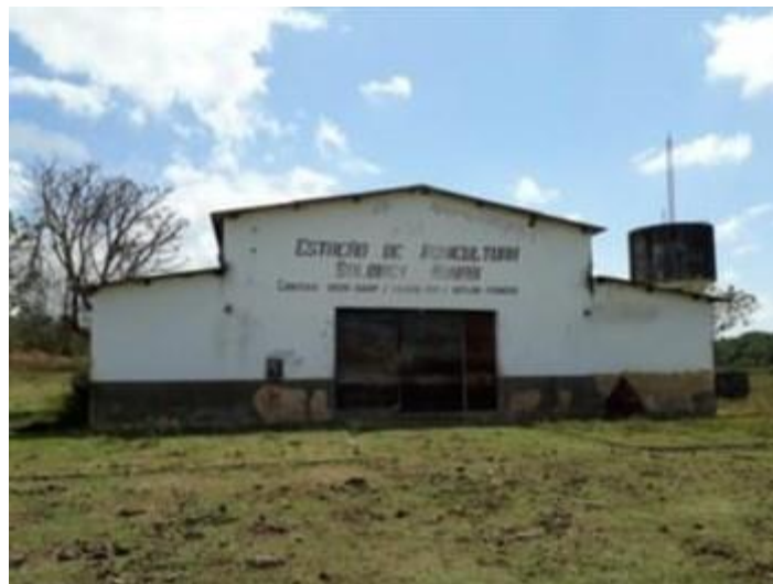
Figura 10 - Galpão de projeto de aquicultura desativado/Cadoz de Baixo
